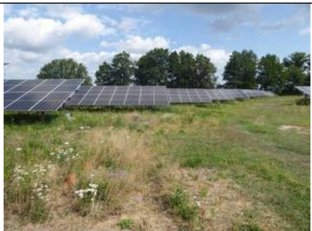
Foto 6: größere Gasse im Westteil des Solarparks (Foto: Wiesner, 13.7.23)
