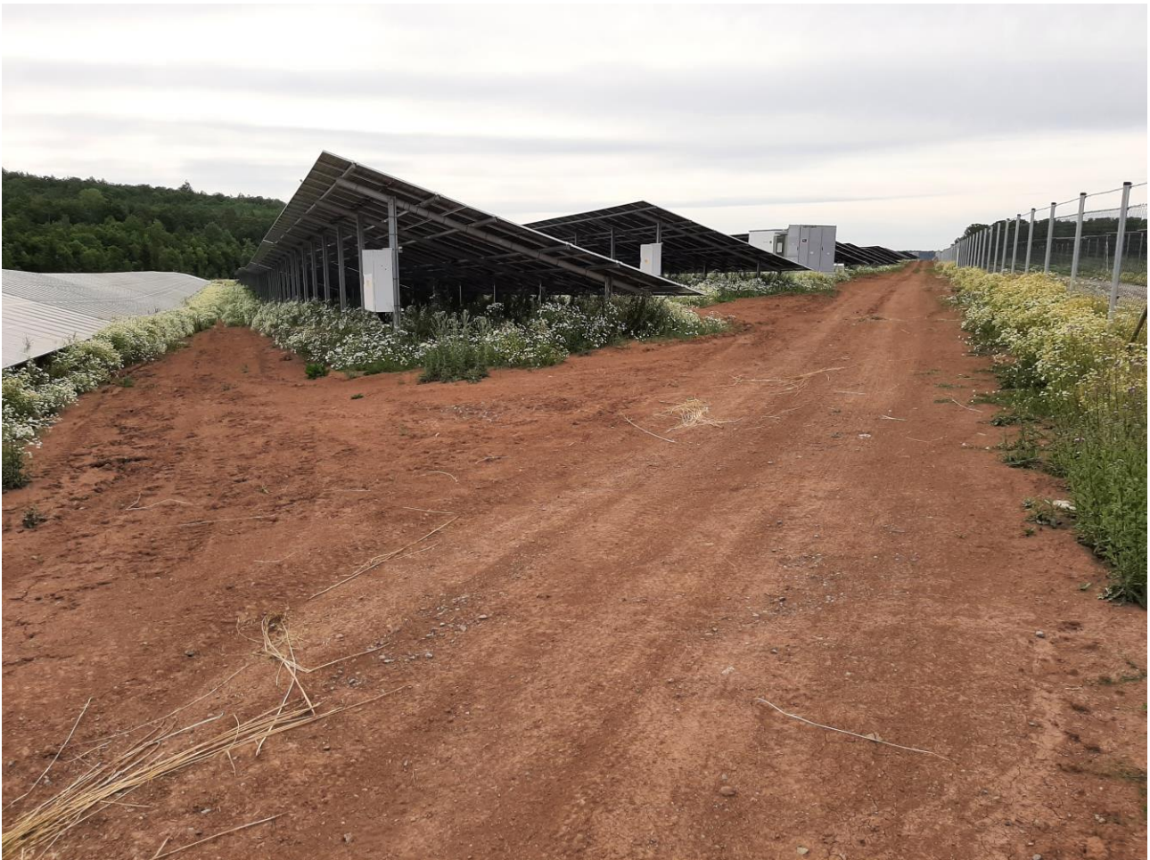
Abbildung 7: Hoher Rohbodenanteil in der PV-Anlage Bundorf
