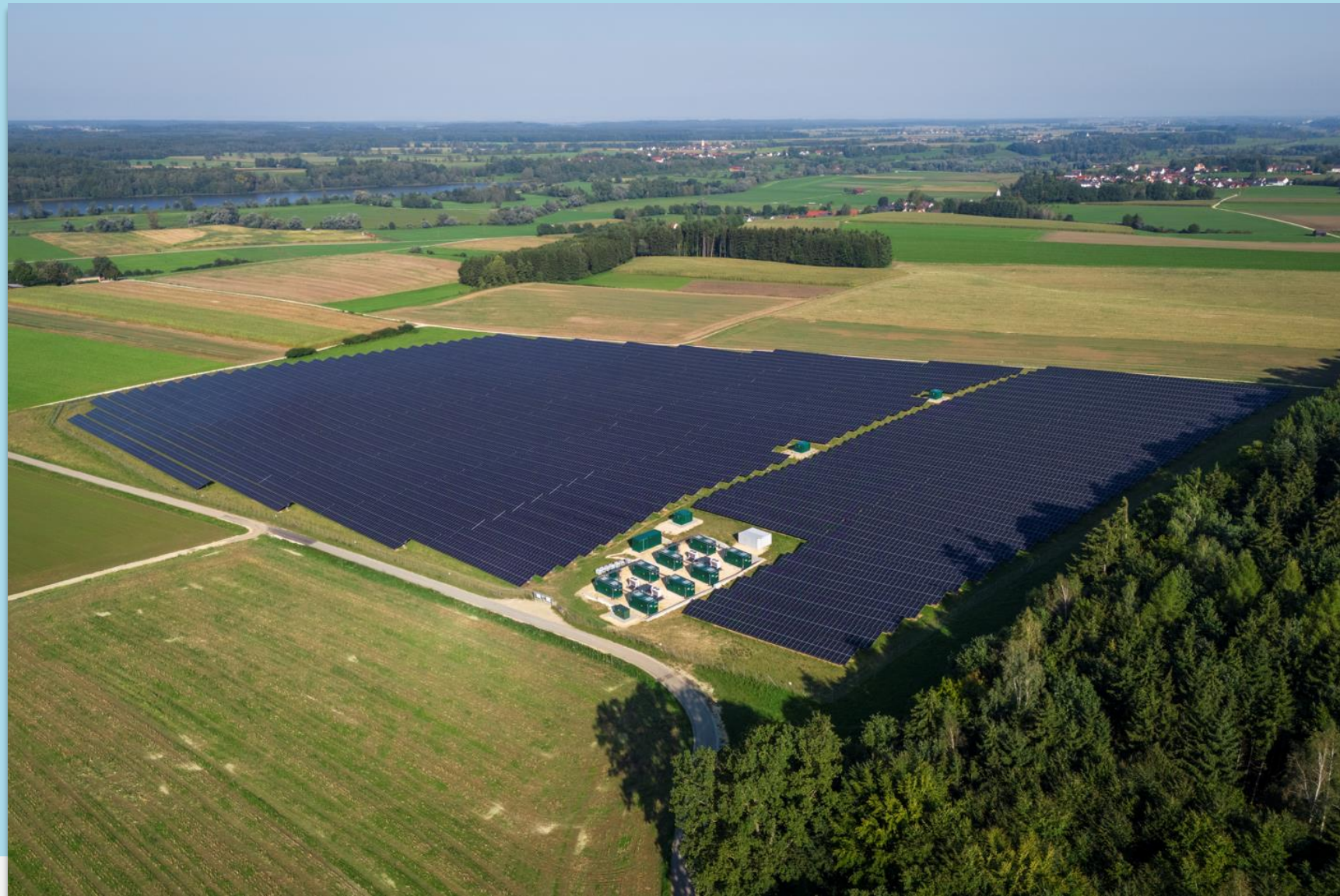
PVA mit BESS 6 MW; 11 MWh, © BayWa r.e.
